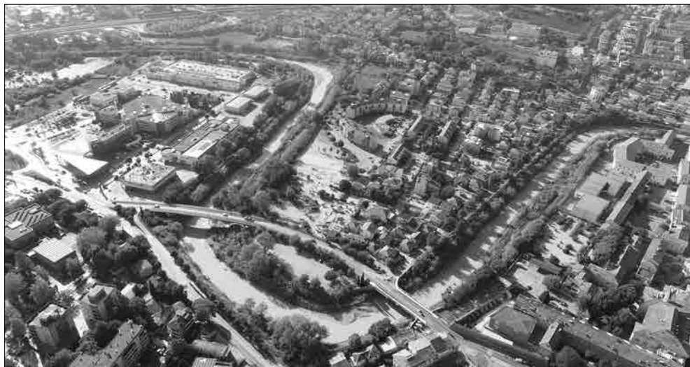
11. Zona della Rivolta dopo l'alluvione del 15-16 settembre 2022 (foto da drone del dr. Paolo Priemeri, direttore dell'Azienda Agraria Mastai Ferretti di Senigallia, 17 settembre 2022, ore 15,35).
